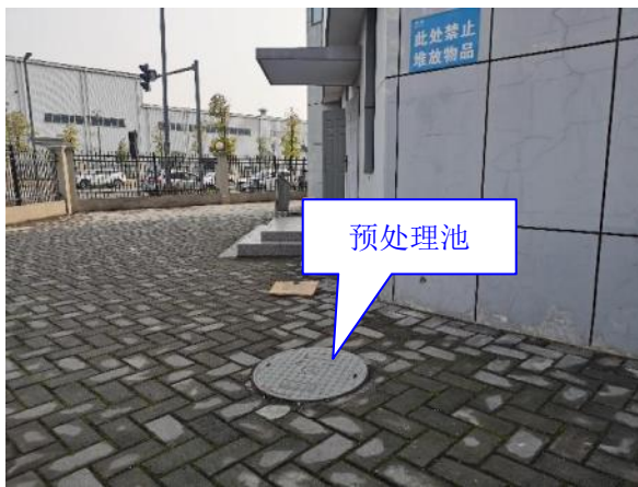
厂区预处理池
