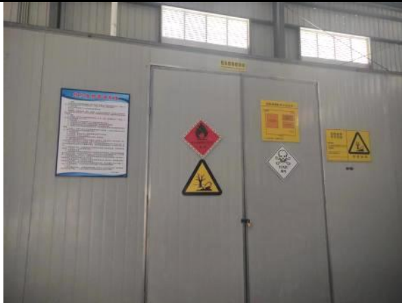
龙华薄膜公司的危险废物暂存间
